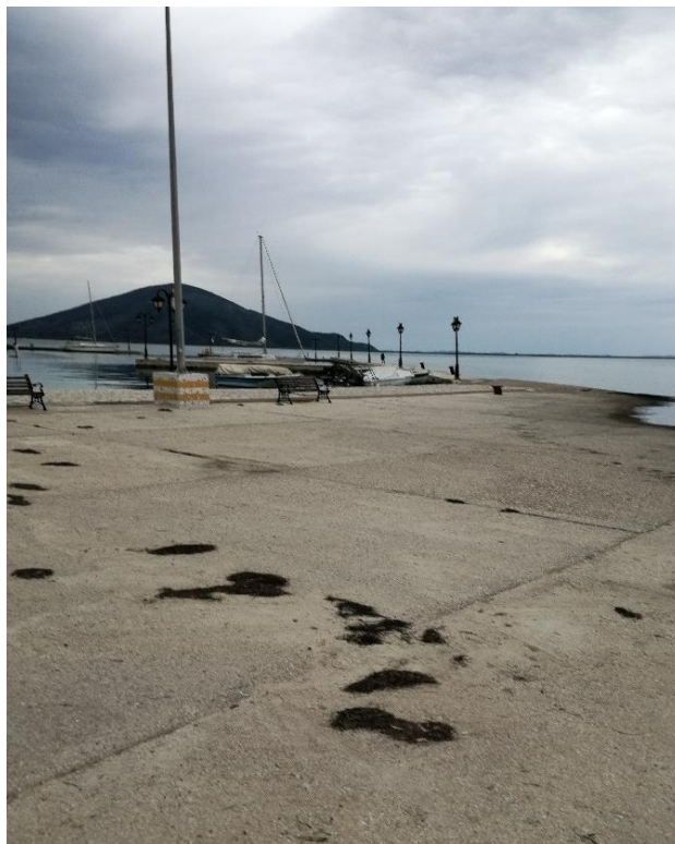
Εικόνα 13-15: Βόρειος χερσαίος χώρος, άποψη προς τα νοτιοδυτικά, στο βάθος διακρίνεται η αρχή του προσήνεμου μώλου του δυτικού λιμενίσκου-καταφυγίου
