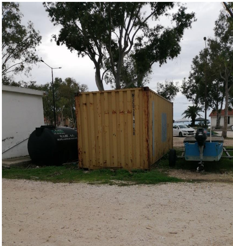
Εικόνα 13-44: Από τα αριστερά προς τα δεξιά, κτίριο WC, πλαστική δεξαμενή προσωρινής συλλογής πετρελαιωδών καταλοίπων και container φύλαξης αντιρρυπαντικού εξοπλισμού, στον κεντρικό ανατολικό χώρο λιμένος Σαγιάδας άποψη προς τα δυτικά-νοτιοδυτικά
