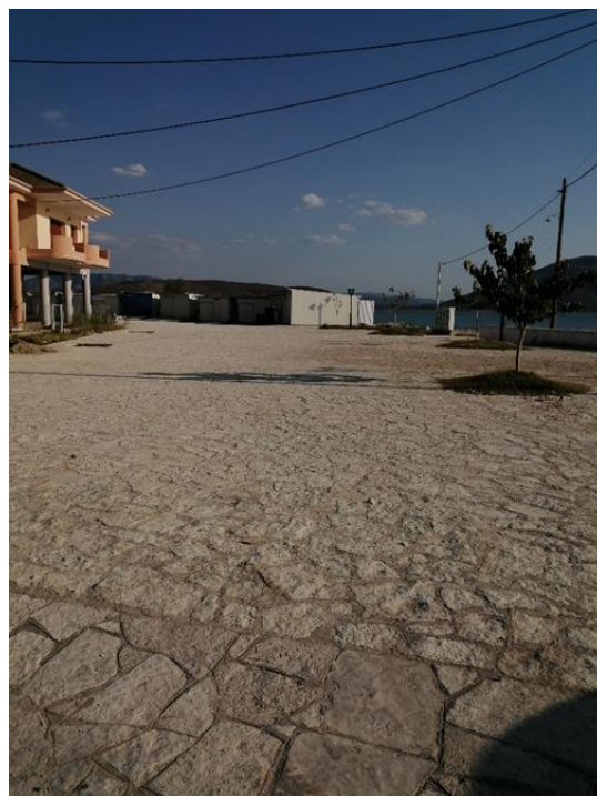
Εικόνες 13-31: Νότιος χερσαίος χώρος, το νοτιότερο τμήμα των δυτικών εγκαταστάσεων λιμένα Σαγιάδας, άποψη προς νότο. Ο χώρος αυτός διαθέτει πλακόστρωση μέχρι τις υφιστάμενες προκατασκευασμένες αποθήκες - ψυγεία των αλιέων, που διακρίνονται στο βάθος των φωτογραφιών
