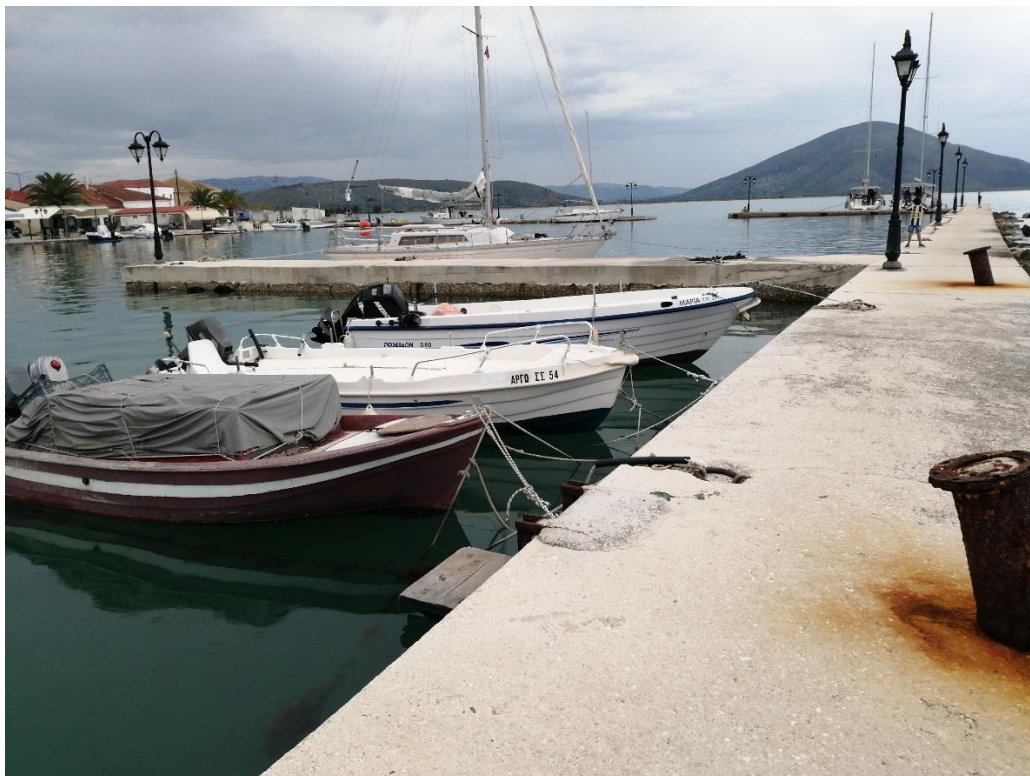
Εικόνες 13-19: Προσήνεμος μώλος και εγκάρσιος προβλήτας δυτικού λιμενίσκου - καταφυγίου, διακρίνεται η νεώτερη κατασκευή από σκυρόδεμα στην ίδια στάθμη με αυτήν του προσήνεμου μώλου, ο εξοπλισμός για την πρόσδεση σκαφών (κρίκοι, δέστρες) και οι εγκατεστημένοι ιστοί φωτισμού, άποψη προς τα νότια, Στον τμήμα του προσήνεμου μώλου μέχρι τον εγκάρσιο προβλήτα δεν φαίνεται να υπάρχει θωράκιση
