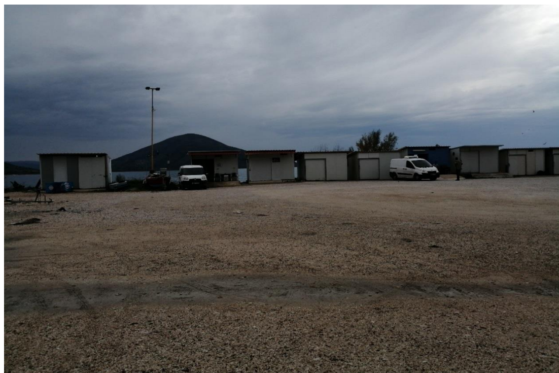
Εικόνα 13-33: Άποψη προς νότο, χώρων παραχώρησης για αποθήκες - ψυγεία για την εξυπηρέτηση των αλιέων, στο νοτιότερο τμήμα της μικρής χερσονήσου λιμένα Σαγιάδας. Ο χερσαίος χώρος προ των αποθηκών, όπως και ο υπόλοιπος ανατολικός χώρος λιμένα Σαγιάδας, όπισθεν των δυτικών λιμενικών εγκαταστάσεων, της σειράς κτισμάτων και της υφιστάμενης ασφαλτοστρωμένης οδού (κατά μήκος της σειράς κτισμάτων), είναι αδιαμόρφωτος, χωρίς τελική επίστρωση με σκληρή επιφάνεια (σκυρόδεμα, άσφαλτος, πλακόστρωση, κ.λπ.) - (1/2)
