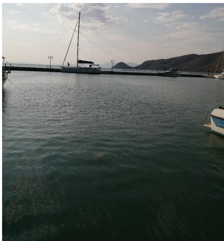
Εικόνα 13-25: Προσήνεμος μώλος και λιμενολεκάνη δυτικού καταφυγίου, άποψη προς τα δυτικά, βορειοδυτικά
