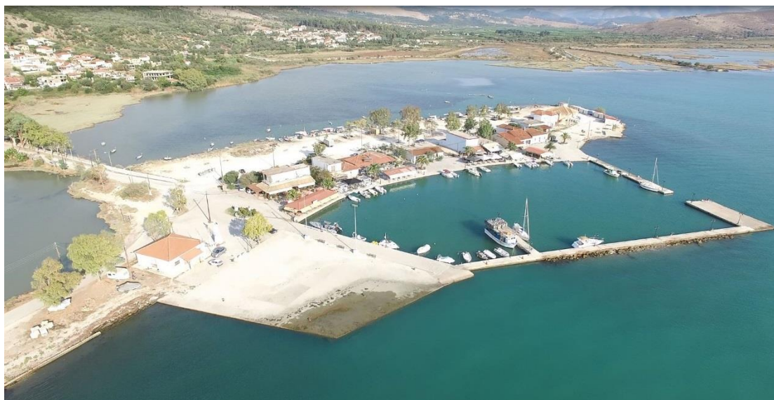
Εικόνα 6-3 Γενική άποψη λιμένα Σαγιάδας και της Α-ΝΑ ευρύτερης παράκτιας περιοχής (λήψη από drone Σεπτ. 2020)
