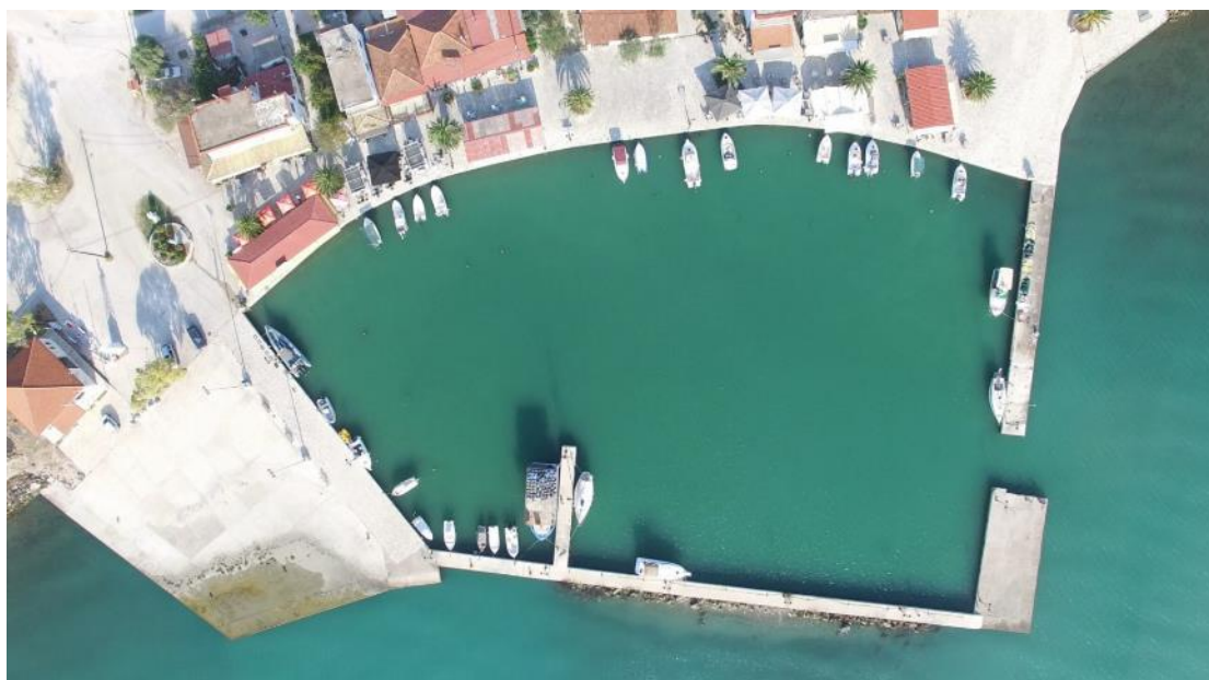
Εικόνα 2-5 Κάτοψη των δυτικών λιμενικών εγκαταστάσεων Σαγιάδας (λήψη από drone Σεπτ. 2020)
