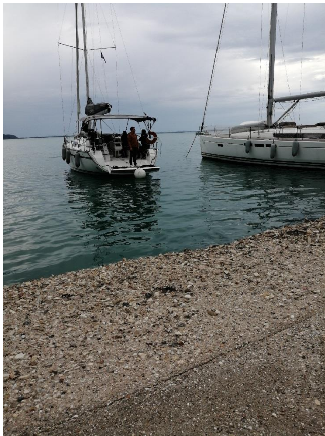
Εικόνα 13-22: Πρόσδεση ιστιοπλοϊκών διερχόμενων σκαφών στην εξωτερική πλευρά του τελευταίου τμήματος του προσήνεμου μώλου, κατά την διάρκεια της επιτόπου επίσκεψης Οκτωβρίου 2020. Άποψη προς νότο. Τα σκάφη αυτά μήκους 15 και 12 μέτρων, μετά από συζήτηση με τους κυβερνήτες τους, δεν επέλεξαν να εισέλθουν εντός των δυτικών εγκαταστάσεων, κυρίως λόγω του μικρού πλάτους εισόδου
