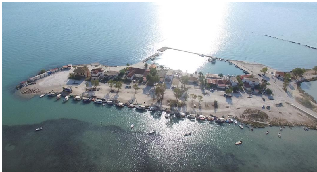
Εικόνα 6-10: Γενική άποψη προς τα δυτικά - βορειοδυτικά των λιμενικών εγκαταστάσεων και λοιπών χώρων Σαγιάδας - σε πρώτο πλάνο ο ανατολικός χερσαίος χώρος και η ζώνη παραβολής μικρών αλιευτικών σκαφών (Άποψη από drone Σεπτ . 2020)
