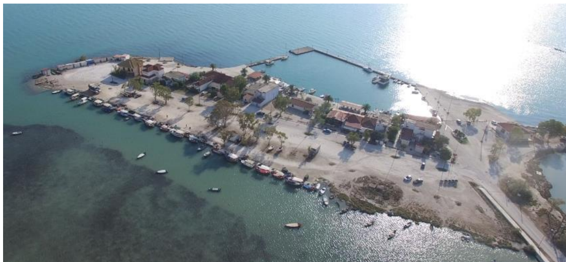
Εικόνα 2-6 Γενική άποψη ανατολικού χερσαίου χώρου και ανατολικού κρηπιδώματος παραβολής μικρών αλιευτικών σκαφών (λήψη από drone Σεπτ. 2020)
