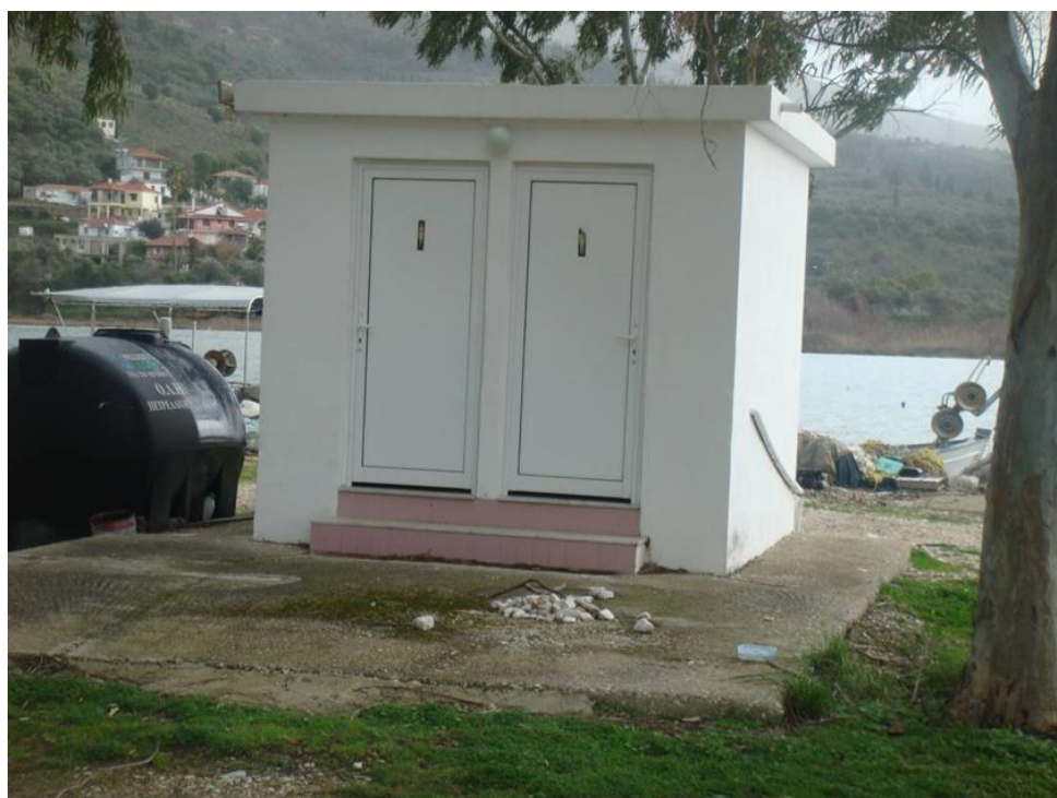
Εικόνα 13-45: Το κτίριο WC στον ανατολικό χερσαίο χώρος λιμένος Σαγιάδας, άποψη προς τα ανατολικά
