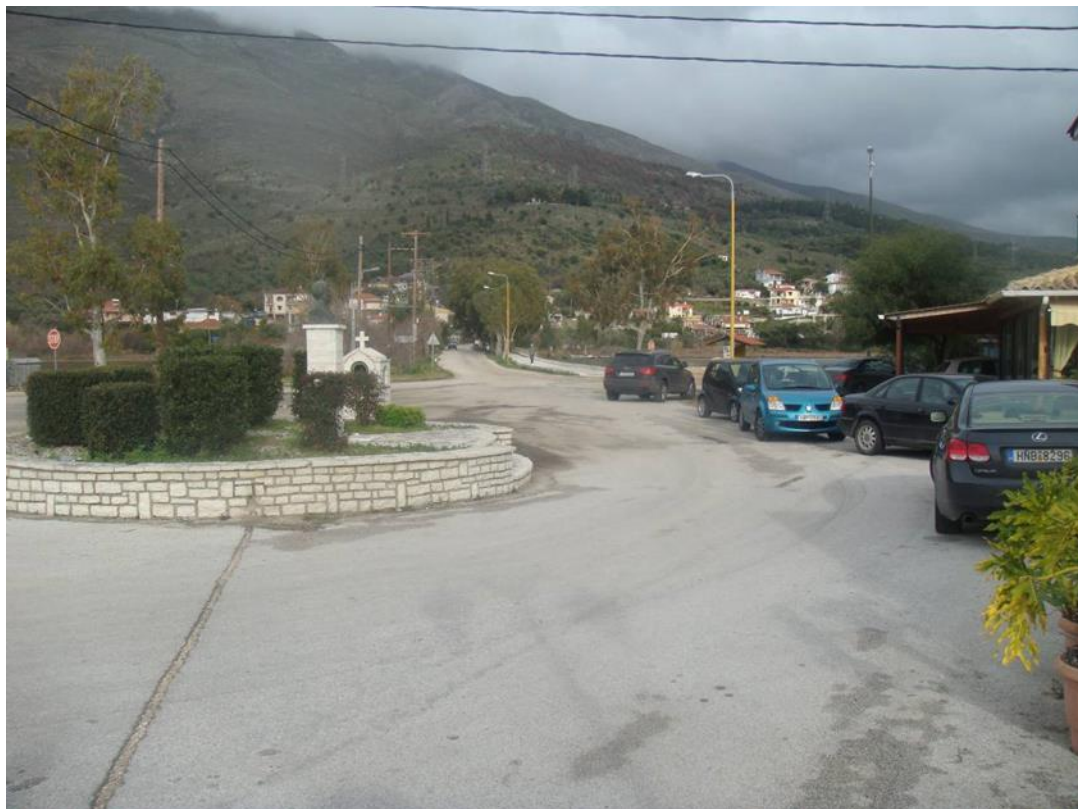
Εικόνα 13-7: Υφιστάμενη οδός εισόδου στο λιμένα Σαγιάδας από τον ομώνυμο οικισμό, διαμόρφωση εισόδου στο βόρειο κερσαίο χώρο του λιμένα, άποψη προς βορειοανατολικά
