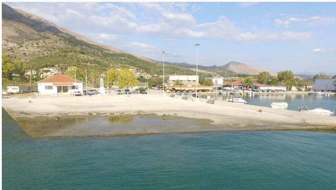
Εικόνα 13-5: Βόρειος χερσαίος χώρος, λήψη από drone, σε πρώτο πλάνο ο τραπεζοειδής προβλήτας στο βάθος της φωτογραφίας ο λιμενικός σταθμός και η είσοδος στις δυτικές λιμενικές εγκαταστάσεις
