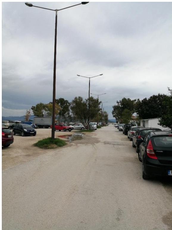
Εικόνα 13-40: Άποψη προς νότο της ασφαλτοστρωμένης οδού κατά μήκος των εκτός χερσαίας ζώνης κτισμάτων στον όπισθεν ανατολικό χώρο του λιμένα Σαγιάδας
