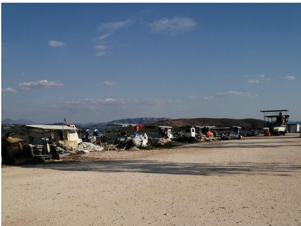
Εικόνα 13-39: Άποψη προς νότο του αδιαμόρφωτου (χωρίς τελική επίστρωση) ανατολικού κερσαίου χώρου του λιμένα Σαγιάδας, στο κρηπίδωμα του οποίου παραβάλλουν μικρά αλιευτικά σκάφη (3/3) - παραβολή σκαφών
